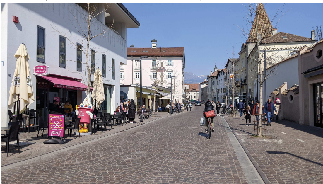
Figura 29 Via Bastioni Minori a Bressanone dopo la ristrutturazione.
